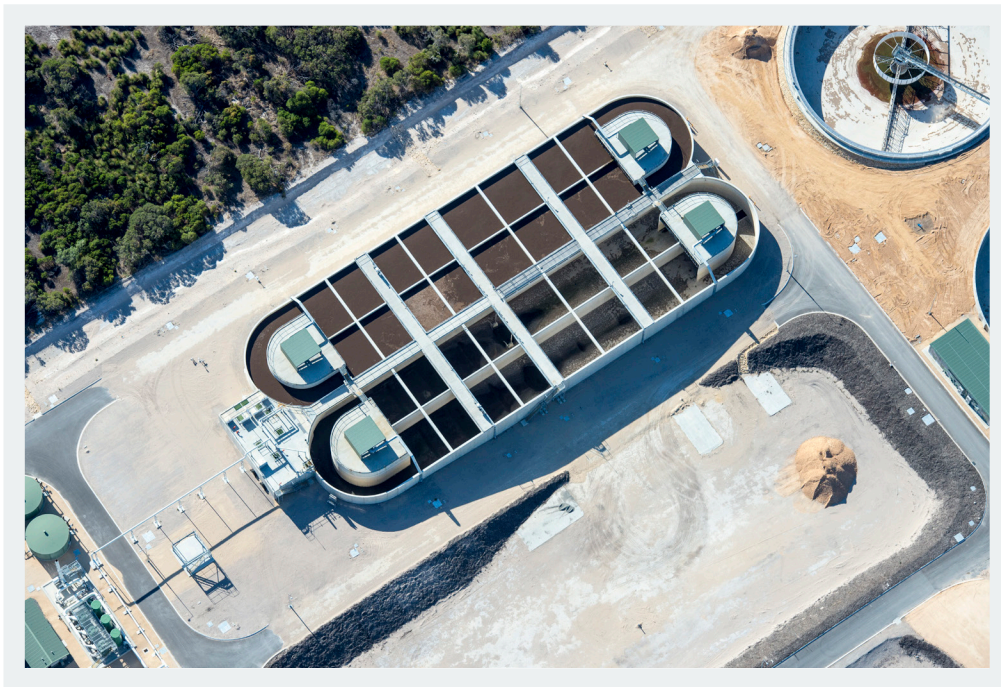
"DBS Racetrack" ZANJAS DE OXIDACIÓN
